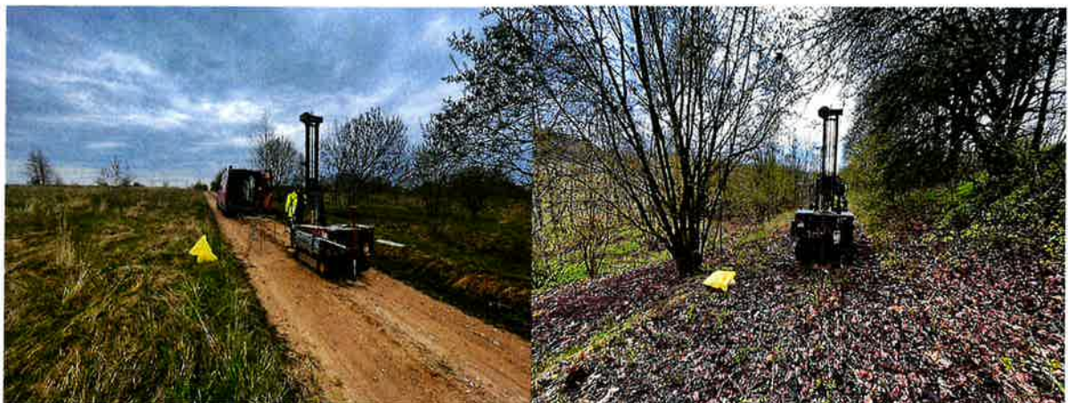
2 pav. Inžinerinių geologinių ir geotechninių tyrimų vieta (dešinėje - Gr.1; CPT-1, kairėje – Gr.5; CPT-5)
